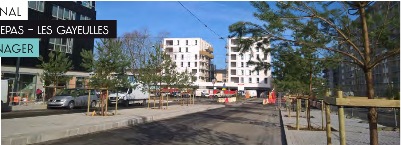
Les travaux de la rue Guy-Ropartz arrivent à leur terme.
